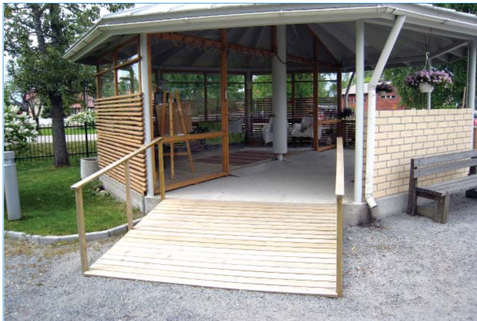
Leveä luiska, jossa laudat ovat poikittain, on turvallinen ja helppokulkuinen. Kuva: Erja Rappe
